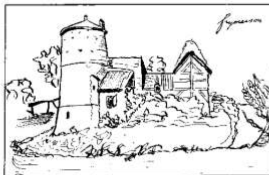
“Kasteel Frimersum” zoals notaris Gullion het rond 1890 zag.
